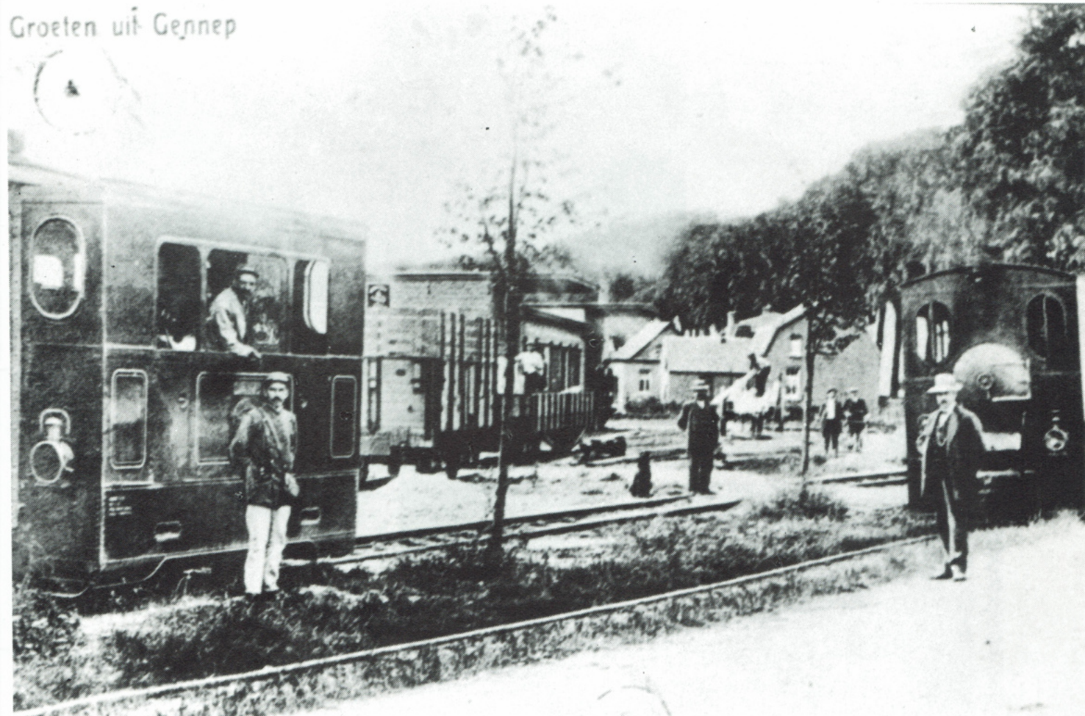
Langs de Rijksweg liep toen nog de tram, en de losplaats van Piet Geurts was rangeerterrein en ook nog trapveld voor de jongens van de Rijksweg. Rechts zien we het nog bijna nieuwe woonhuis van Van de Loo, toen nog zonder erker. In de linkse locomotief staat Bert Snijdens, daarvoor zien we machinist Hendriks en rechts met hoed Grootvader Piet Geurts. Op de achtergrond wordt een wagon met balken overgeladen, misschien wel voor het timmerbedrijf van Oom Thei Kersten. Zou voerman Thissen hem daarbij behulpzaam zijn?
